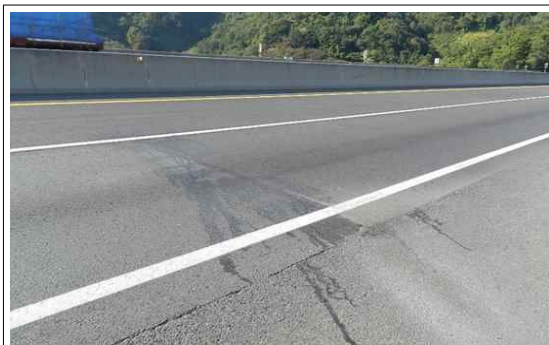
교면포장 상행선 S10 라벨링 보수
