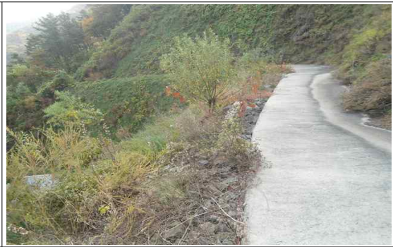
사면(중점부-정면) STA.0+ 0 1소단배수로 낙석적치
