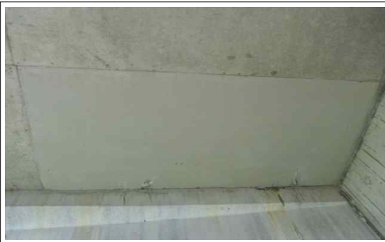
바닥판하면 상행선 S2 균열 보수
