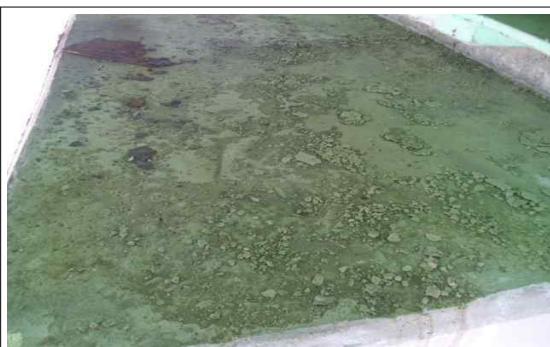
교각 상행선 P3 코핑부 콘크리트 박락
