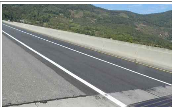
교면포장 하행선 S5 라벨링 보수
