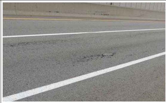
교면포장 상행선 S3 라벨링
